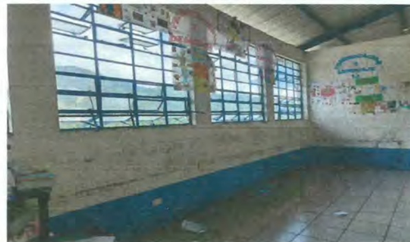
Foto 2: Mantenimiento de paredes exteriores e interiores con aplicación de pintura en todos los módulos.
