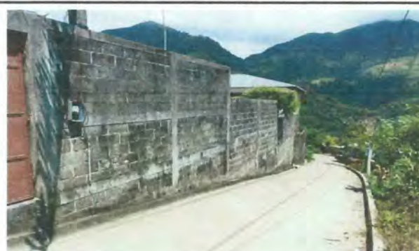
Foto 4: Área del muro perimetral lado frontal del centro educativo que será intervenido con repellado en sus paredes.
