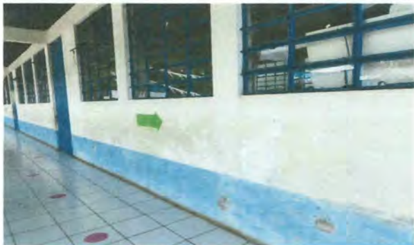
Foto 1: Mantenimiento de paredes exteriores e interiores con aplicación de pintura en todos los módulos.
